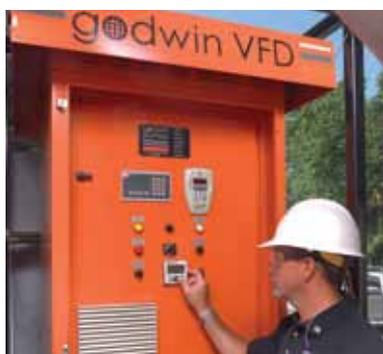
Контроллеры частотно-регулируемого привода (VFD) обеспечивают возможность бесступенчатой регулировки скорости и плавное и контролируемое увеличение или уменьшение числа оборотов насосов с электроприводом.
