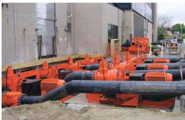
Восемь насосов CD400M диаметром 400 мм с электроприводом были опущены еще на 1,2 м и расположены таким образом, чтобы откачивать продукт из водоприемника.
