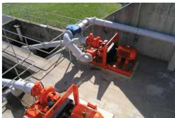
Два стационарных насоса DPC300 диаметром 300 мм с электроприводом были установлены взамен двух шнековых насосов, перекачивавших сточные воды из вторичного капельного биофильтра в камеру хлорирования, а затем в выпускной трубопровод.
