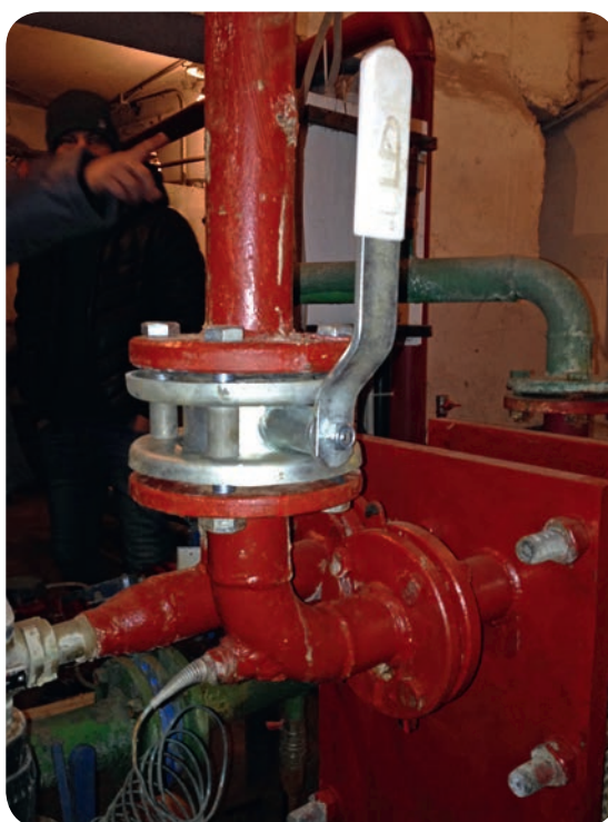
КОНТУР ГВС ПОСЛЕ ПЛАСТИНЧАТОГО ТЕПЛООБМЕННИКА
